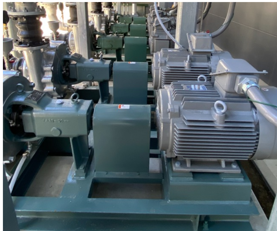
500KW排熱 4,000m 3 /min 37KW級省エネポンプ
