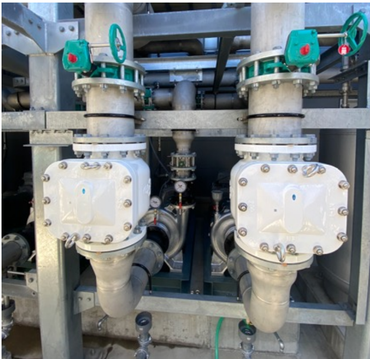
500KW排熱 ストレーナ
