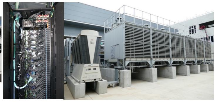
大型データセンターでヒートポンプは使わない。クーリングタワー+冷水チラーとなる。
