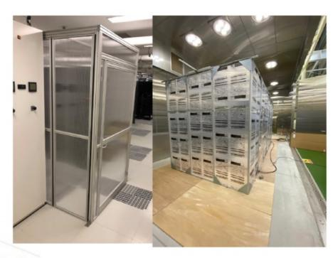
キャッピングが十分に設備され シュートサーキットを少なく サーバ吸気排気の温度傾斜 8℃から10℃とする
